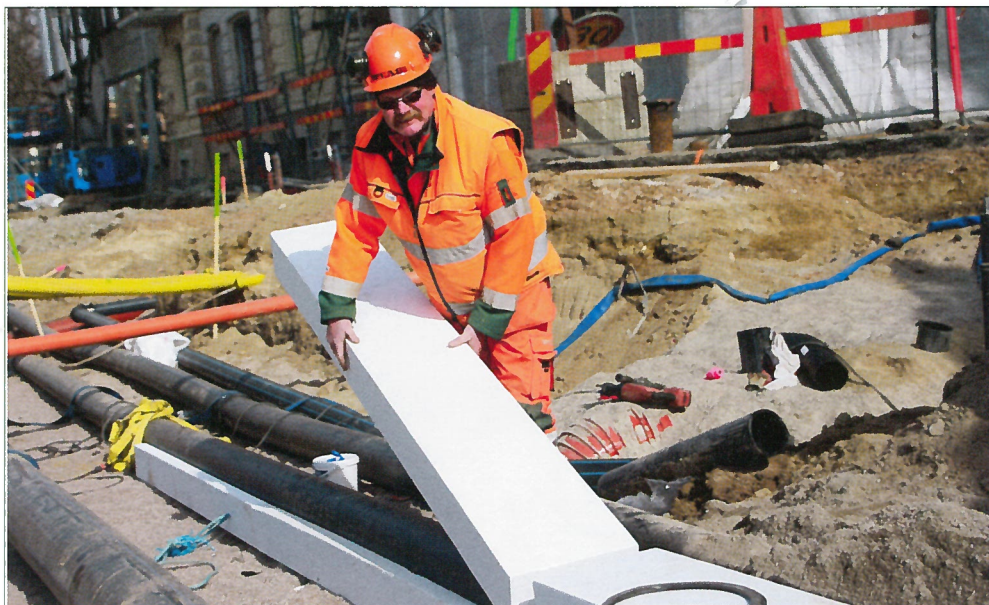
Rörläggaren Per Svensson tycker att plaströr är lätta att hantera. Här isolerar han det framledningsrör som ska förse rådhuset i Kristianstad med fjärrkyla. Foto: PER ERIKSSON
