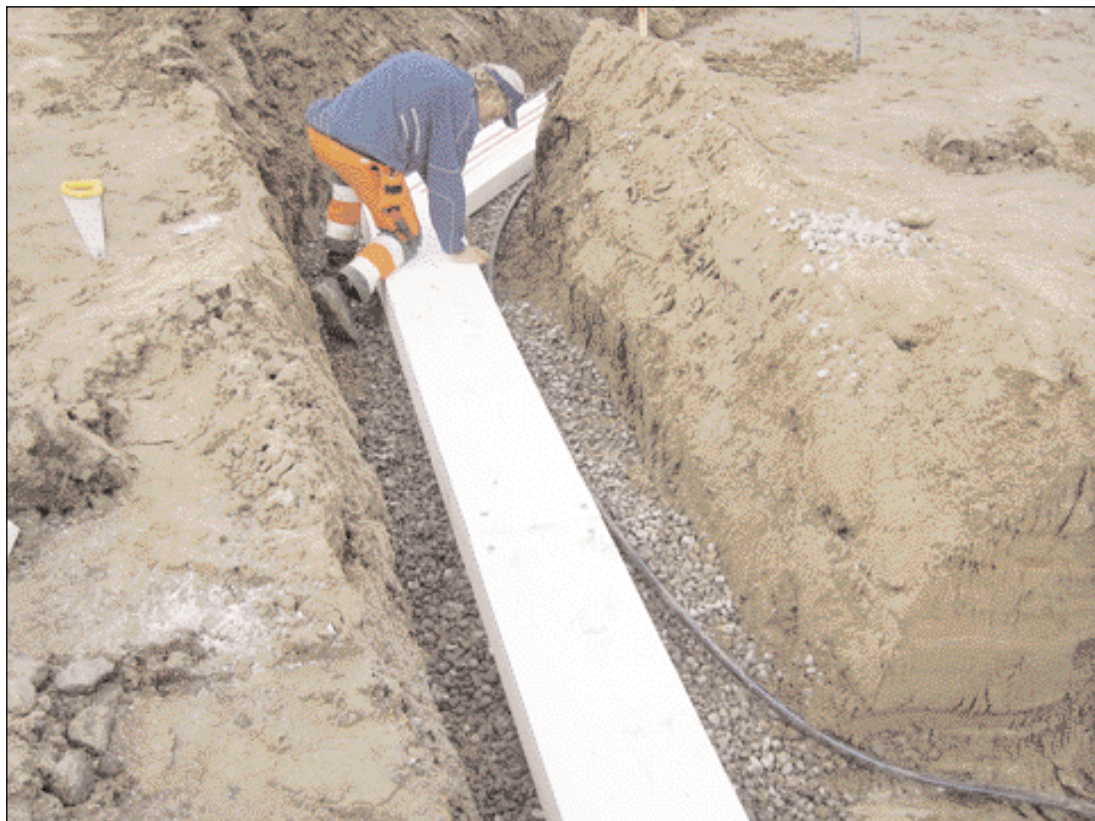
Fjärrvärmerören till och från det nya villaområdet på Stavstensudde i Trelleborg är redan på plats. Ledningarna ligger inbäddade i frigolit.
