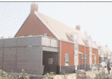
Kommunen har på ett tidigt stadium beslutat att det nya villaområdet ska värmas med fjärrvärme. Foto: Riksbyggen
