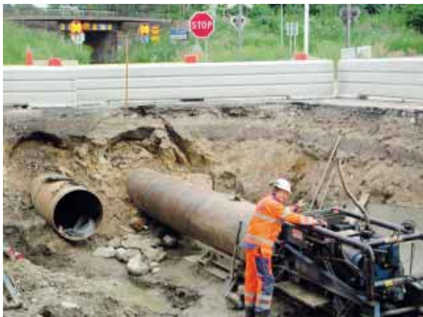
Augerborrning under väg för fjärrvärmeledning mellan Lund och Eslöv
