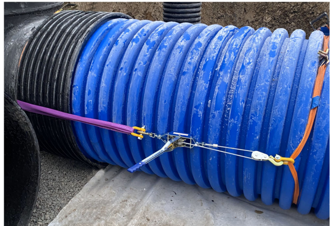
Sammanfogning med spaklyftblock
